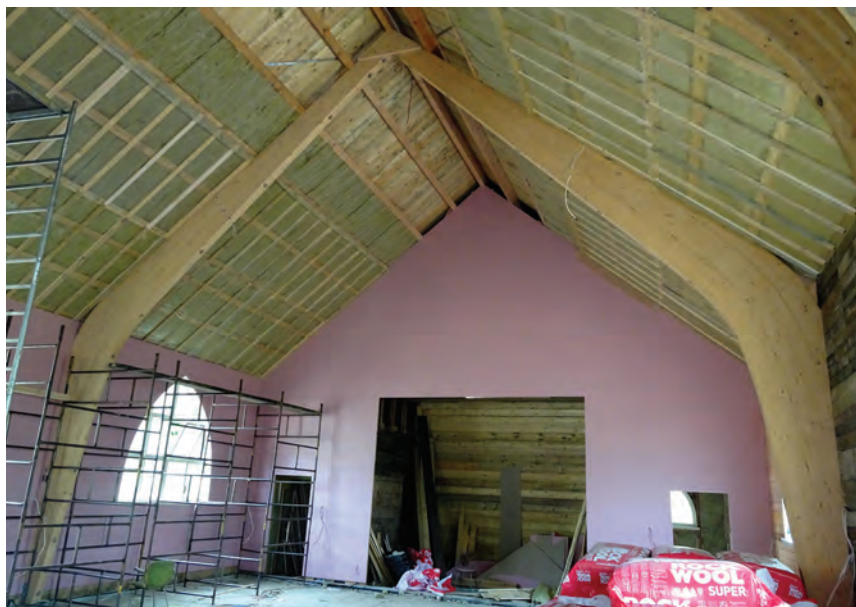
Fot. 10. Nawa kościoła z Bytomia-Bobrza w trakcie układania płyt wykończeniowych na ścianach. Widoczna warstwa termoizolacyjna z wełny mineralnej osłoniętej folią paroizolacyjną na stropie jeszcze przed położeniem płyt gipsowo-kartonowych sufitu, 2017 rok
