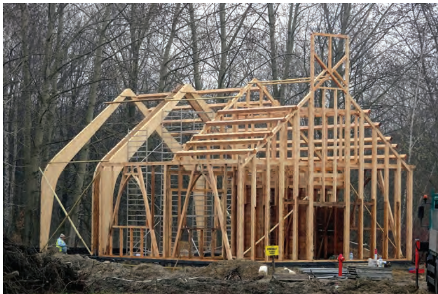
Fot. 5. Montaż konstrukcji kościoła z Bytomia-Bobrka, marzec 2017 roku. Widoczne dźwigary nowe (jaśniejsze) i para dźwigarów oryginalnych
