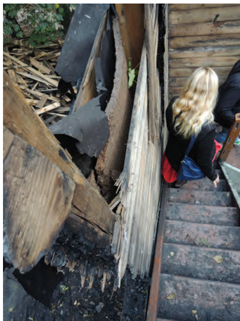
Fot. 7. Kościół z Bytomia-Bobrka w trakcie rozbiórki. Widoczna budowa ściany kościoła z wypełnieniem z papy i płyt pilśniowych
