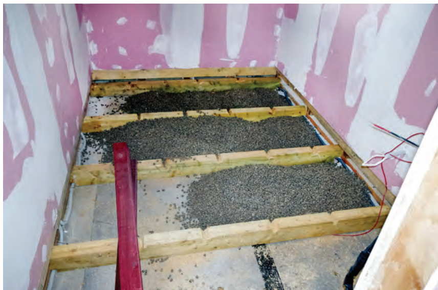
Fot. 6. Kościół z Bytomia-Bobrza, zakrystia. Nacięcia wentylacyjne w legarach podłogi
