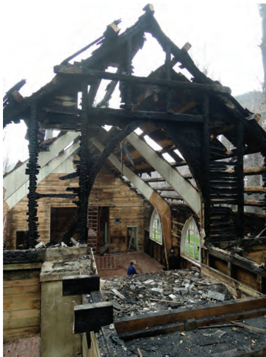
Fot. 4. Kościół z Bytomia-Bobrka w trakcie rozbiórki
