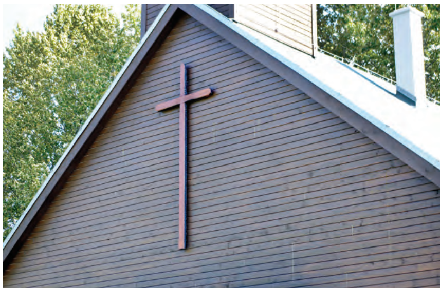
Fot.1. Krzyż znajdujący się na ścianie frontowej
