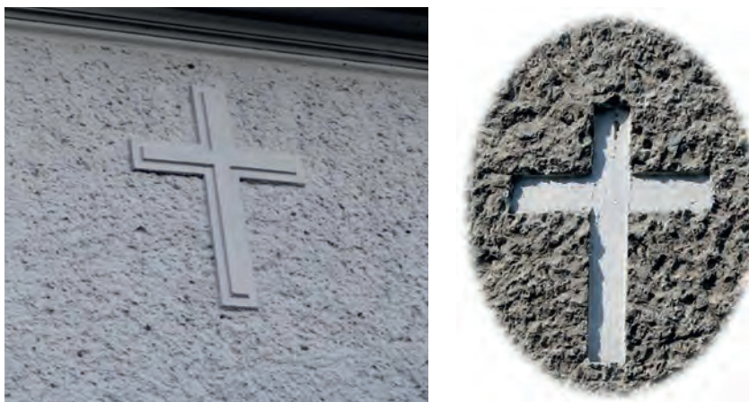
Fot. 8–9. Znak krzyża wyżłobiony na budynku (od lewej: wypukły, wklęsły)
