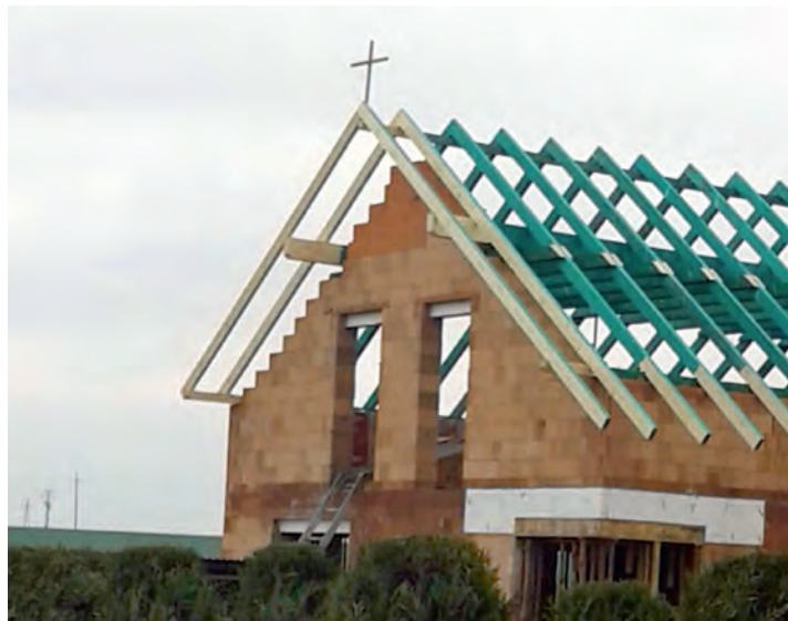
Fot. 19. Umiejscowienie znaku krzyża na wieżbie budowanego domu, Krzyżanowice (pow. raciborski)
