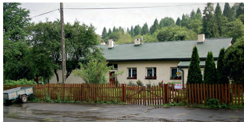
Fot. 3. Współczesna, bezstylowa zabudowa Bieszczadów. Brak związku z tradycyjnym budownictwem – nie wykorzystano elementów regionalnych, zastosowano współczesne formy, detale i materiały budowlane
