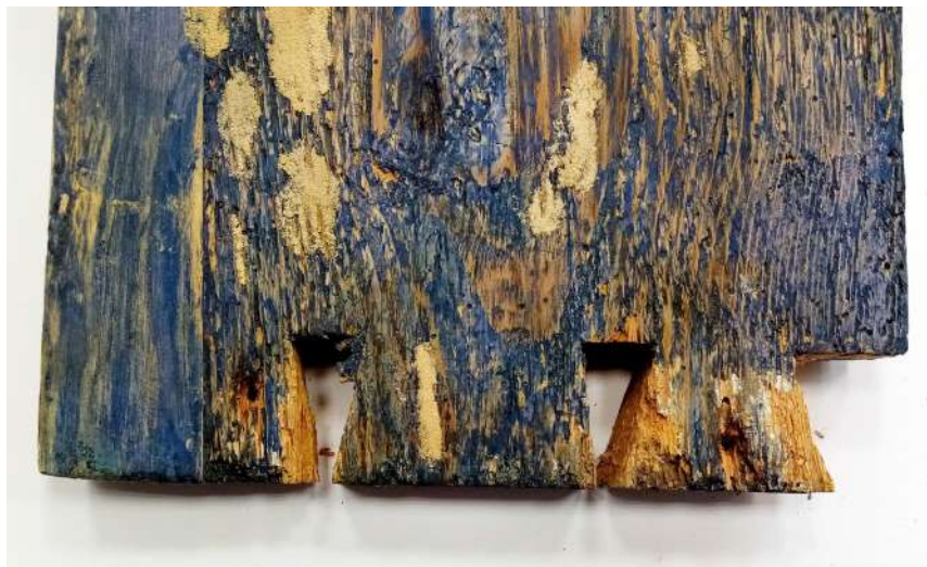
Ryc. 4. Zdjęcie zdegradowanych połączeń ciesielskich podnóżka Fot. M. Książek, 2021 rok
