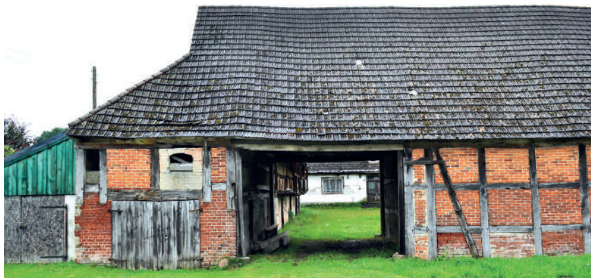
Ryc. 21. Dziadowo 12–12A, brama wjazdowa w zagrodzie czworobocznej, stan na lipiec 2024 roku Fot. Agnieszka Słowińska
