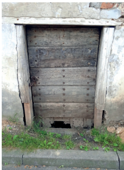
Ryc. 11. Drzwi wejściowe do spichlerza w Raciborzu-Sudole przed renowacją, 2019 rok Fot. Maria Olejarnik
