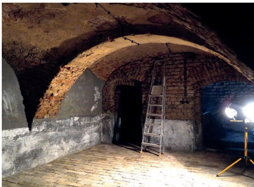
Ryc. 10. Piwnica w spichlerzu w Raciborzu-Sudole po wykonaniu izolacji przeciwwilgociowej i posadzki, 2023 rok Fot. Cezariusz Magott
