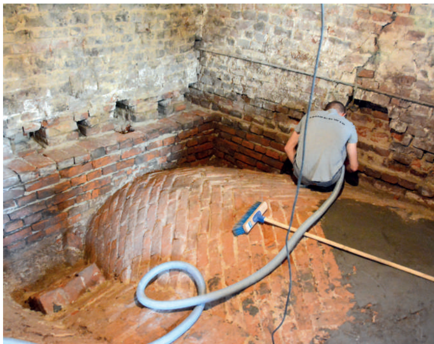
Ryc. 8. Prace naprawcze sklepienia nad piwnicą spichlerza w Raciborzu-Sudole, 2022 rok Fot. Cezariusz Magott
