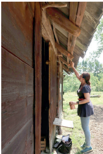
Ryc. 7. Znakowanie elementów konstrukcyjnych stodoły. Widoczna leksza płatew, 2023 rok Fot. Anna Ozaist-Przybyła
