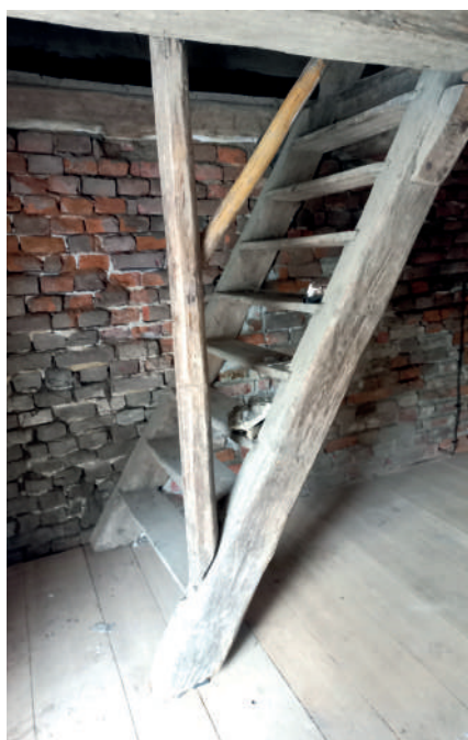
Ryc. 15. Widok na schody na piętro w spichlerzu w Racibórz-Sudole, 2023 rok Fot. Maria Olejarnik
