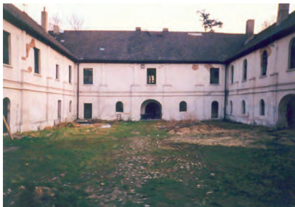
Fot. 1. Dziedziniec Zamku Tarnowice Stare przed podjęciem prac renowacyjnych
