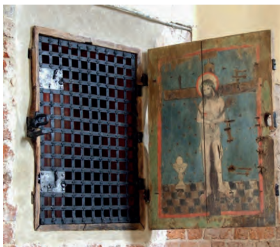
Fot. 7. Tabernakulum ścienne po konserwacji i restauracji, umieszczone w pierwotnej niszy w kościele pw. św. Piotra i Pawła w Mariance Pastęckiej. Konstrukcja nośna jest niewidoczna, natomiast umożliwiła uzyskanie dystansu pomiędzy drewnem szafki sakrarium a murem, sposób montażu pozwala na cyrkulację powietrza
