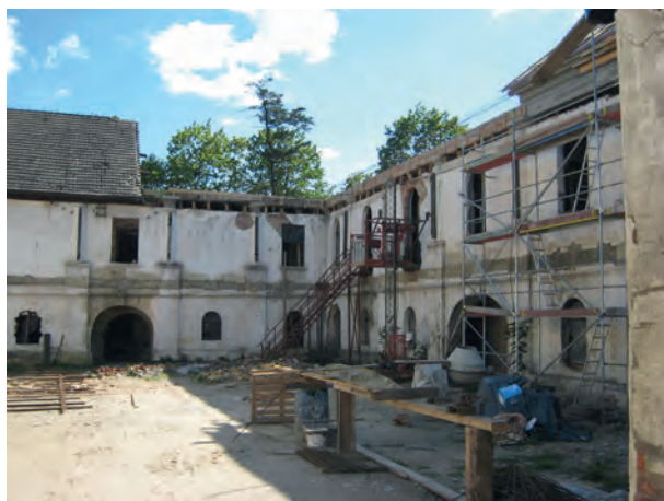
Fot. 2. Dziedziniec Zamku Tarnowice Stare w trakcie prac renowacyjnych
