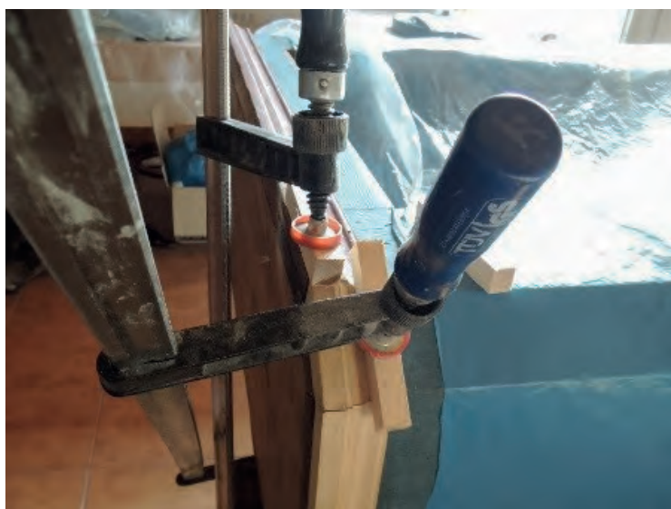
Fot. 7. Gzyms w trakcie konserwacji
