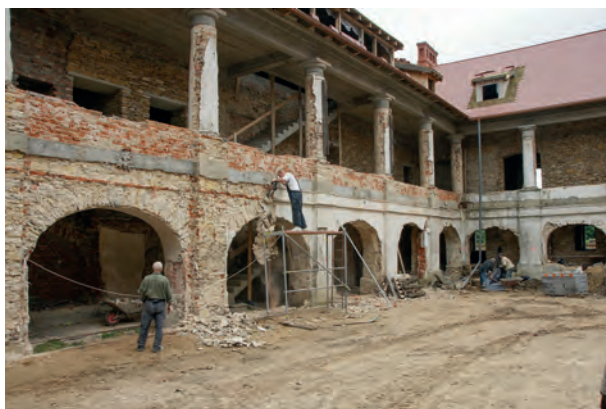
Fot. 3. Działdziniec Zamku Tarnobrzeg Stare w trakcie prac remontowych
