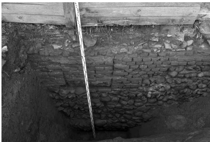
Fot. 6. Zborowskie, pow. lubliniecki. Wykop 3/2013 z widoczną ścianą tarczową piwnicy oraz zamurowanym otworem
