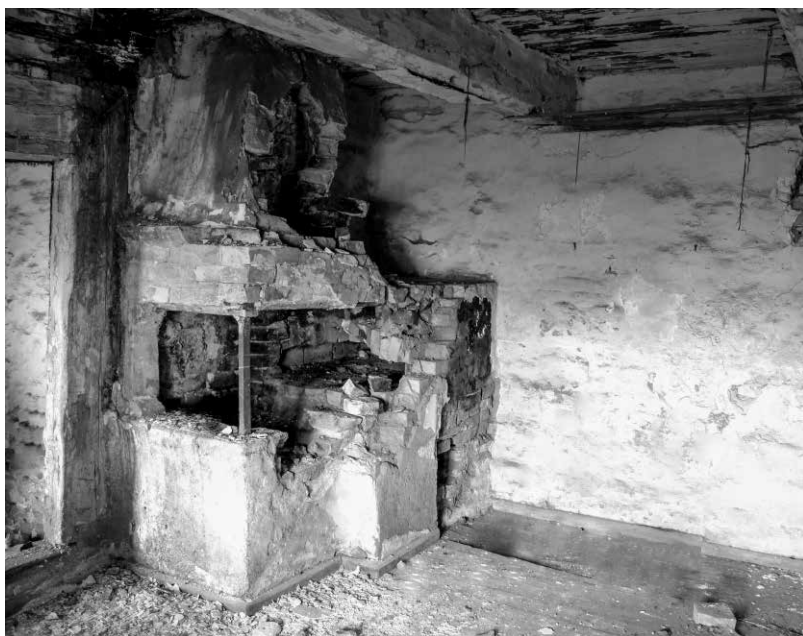
Fot. 5. Zborowskie, pow. lubliniecki. Piec kuchenny/grzewczy dostawiony do centralnie usytuowanego komina
