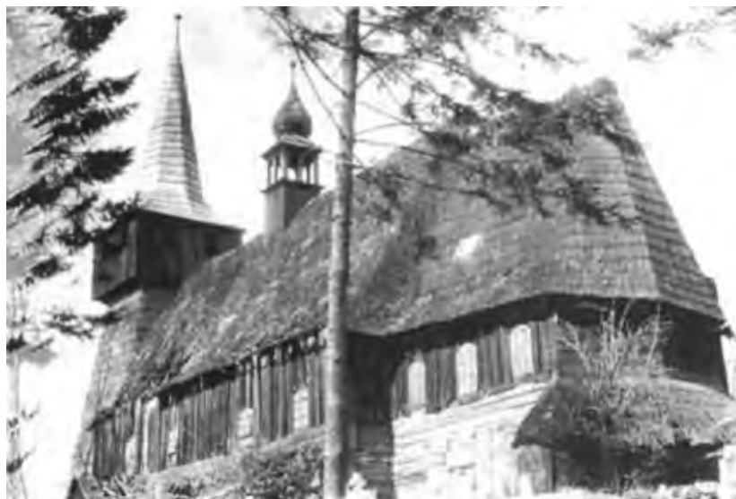
Fot. 1. Kościół pw. Nawiedzenia Najświętszej Marii Panny w Połomi wybudowany w 1575 roku. Zawalił się 30 lipca 1969 roku wieczorem podczas szalejącej wichury, a ocalała wieża dzwonna została przeniesiona do Wisły-Głębc
