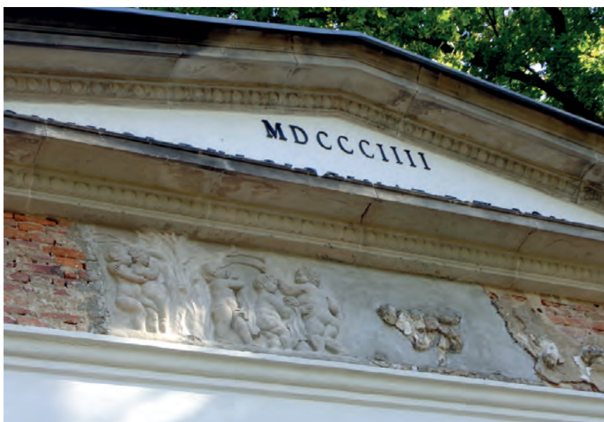
Fot. 3. Fryz Pawilonu w Bukowcu
