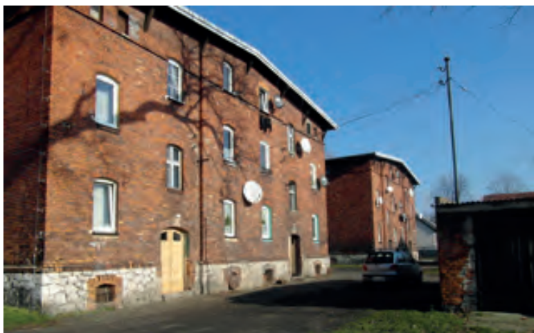
Fot. 11. Dwa familoki widziane od strony południowej, z widocznymi licznymi modernizacjami budynków
