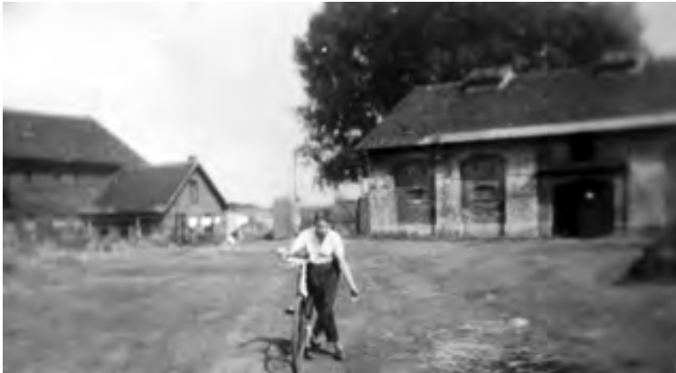
Fot. 7. Północno-zachodni narożnik podwórza
