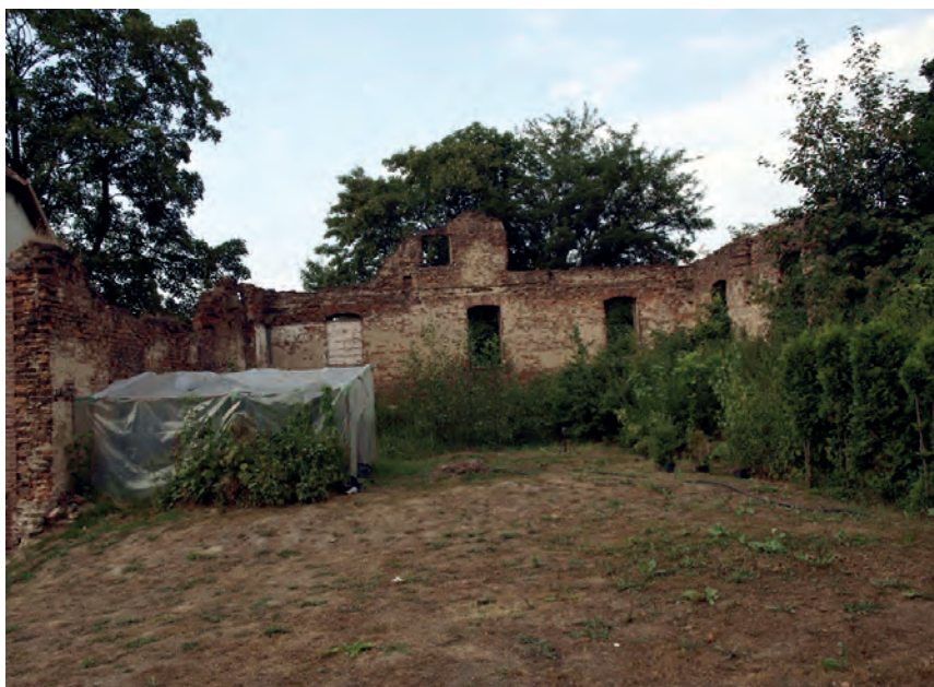
Fot. 2. Krowiarki, pozostałości ujeżdżalni
