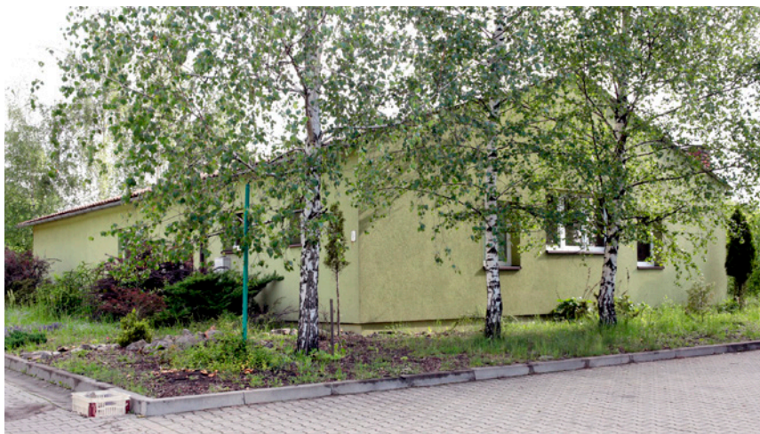
Fot. 3. Budynek pracowni konserwatorskiej na zapleczu gospodarczym
