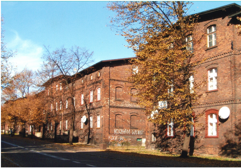
Ryc. 11. Współczesny wygląd familoków przy ulicy Przemysłowej, na terenie dawnej kolonii w dzielnicy Paruszowiec-Piaski
